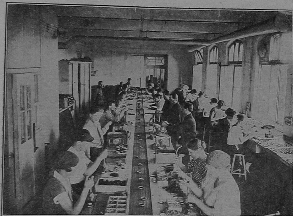
Конвейерная сборка телефонов на заводе „Красная Заря“.
